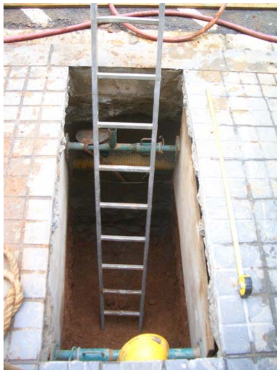
Vista S-N de la rasa amb diferents serveis en la paret N
