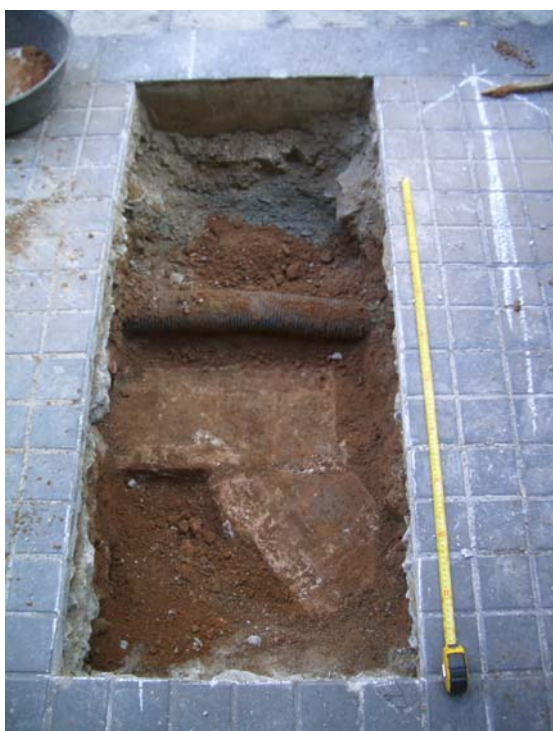
Vista S-N de la rasa amb diferents serveis per sota l'actual vorera
